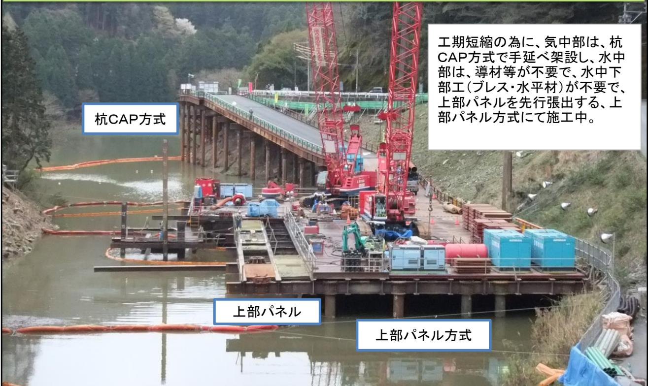
工期短縮の為に、気中部は、杭CAP方式で手延べ架設し、水中中部は、導材等が不要で、水中下部工(プレス・水平材)が不要で、上部パネルを先行張出する、上部パネル方式にて施工中。
